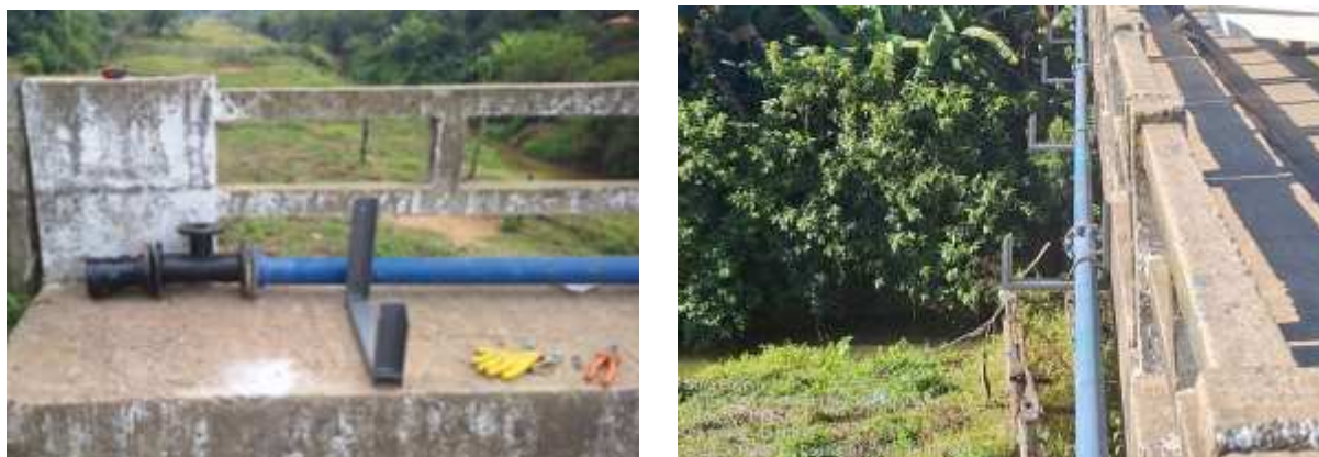
Figura 12 – Execução de travessia sobre Rio Paraibuna no distrito de chapéu d'uvas.
