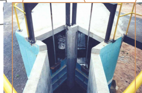
Detalhe das comportas da Etapa de Tratamento Preliminar da ETE Barbosa Lage.
