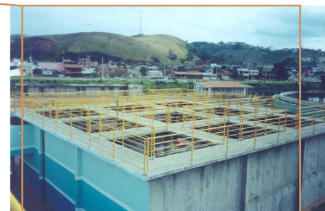
Detalhe do Tanque Digestor Aeróbio do Tratamento Secundário da ETE Barbosa Lage.
