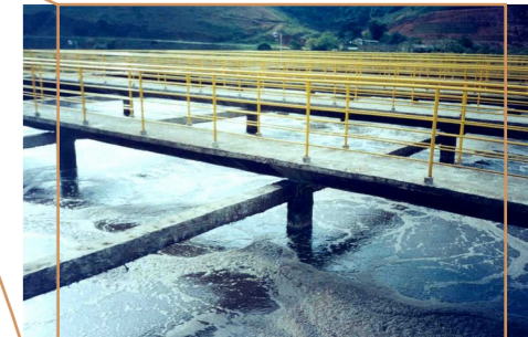
Detalhe do Tanque de Aeração do Tratamento Secundário da ETE Barbosa Lage.
