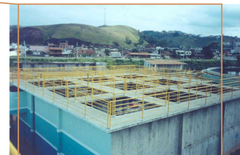
Detalhe do Tanque Digestor Aerbio do Tratamento Secundário da ETE Barbosa Lage.
