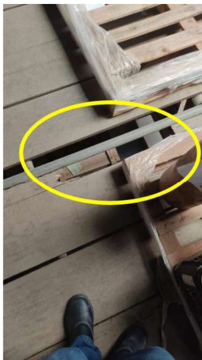
Figura 21: Falha no assoalho do mezanino
