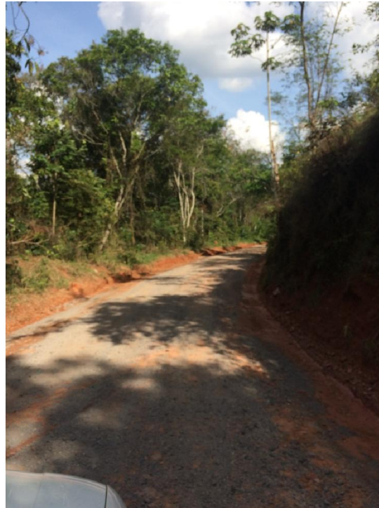
Espalhamento de Escória - Av. Eudócio Infante Vieira (Estrada Velha da Represa). Trecho Executado – Estaca 323 à 297.
