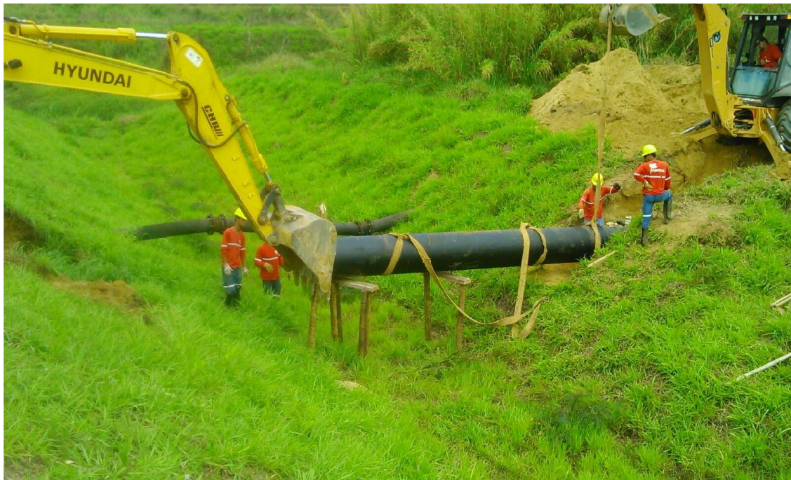
Travessia de Canal de Drenagem Entre Estacas 13 e 14
